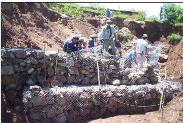
Construcción de gabiones en áreas de deslizamiento en la comunidad de Quequesque, en el municipio de Quzaltepeque.
