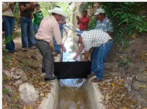
FIGURA 36. Revestimiento de 212 mt. de canal de conducción e instalación de 20 compuertas, Sistema de riego agrícola, La Conquista, Quezaltepeque.
