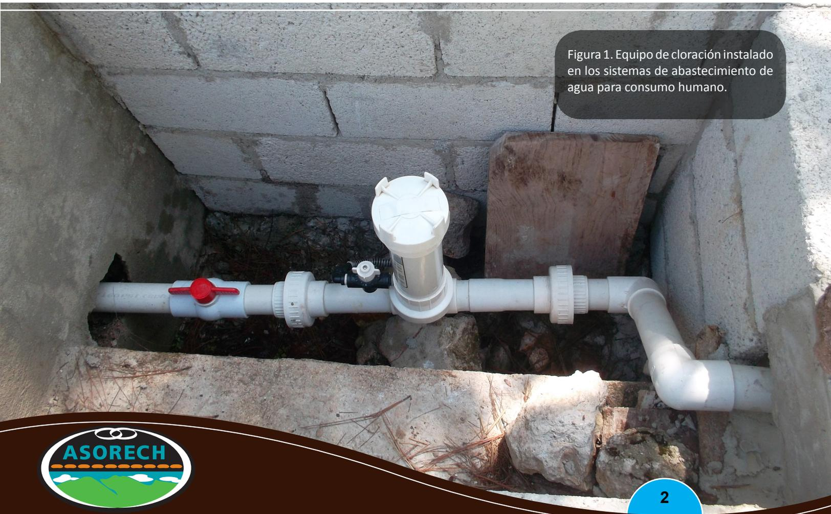
Figura 1. Equipo de cloración instalado en los sistemas de abastecimiento de agua para consumo humano.
